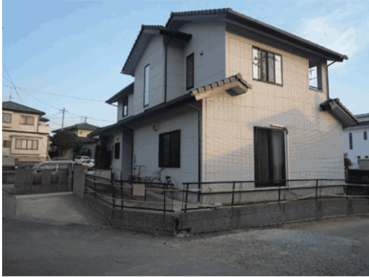
(H1) 南北路地（東側）の住宅傾斜 （北西→南東）
