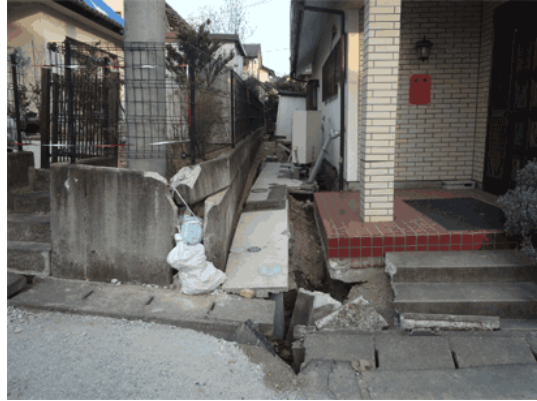
(N1) 南北路地（西2番目）沿いの住宅 （北西→南東）
