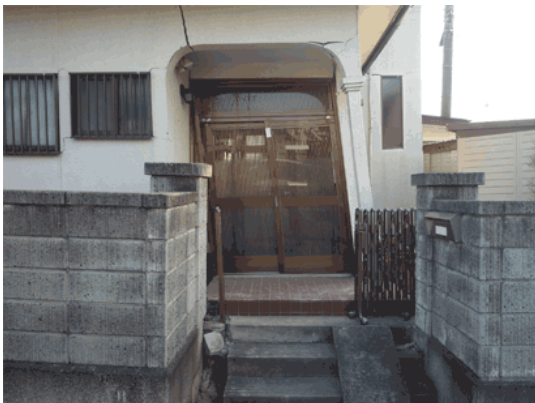
(x2) 玄関付近 (北東→南西)
