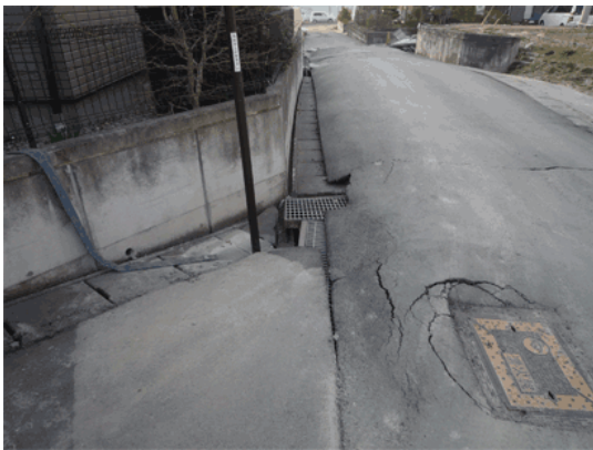
(w) 東西路地のアスファルト移動 (南東→北西)
