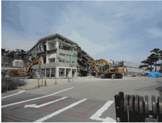
(a) 4号線道路側からの様子 (西→東)
