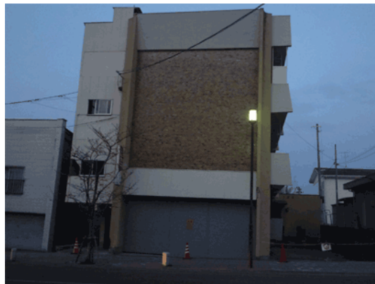
(h) 上記 RC 建物の西側道路からの様子 (西→東)
