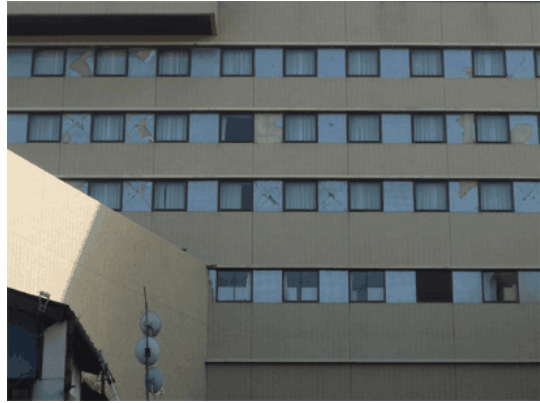
(g) RC 建物（多数の斜めひび割れ） （北→南）
