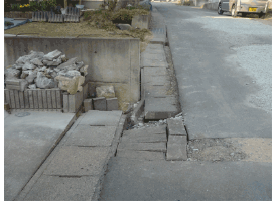
(r1) 造成地南北路地（西側）の側溝移動 （南西→北東）
