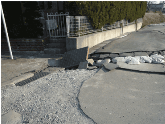
(c) 西側道路沿いの歩道 (北→南)
