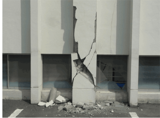
(b) 南から2番目の柱基部 （西→東）
