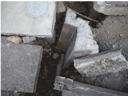
(N2) 移動した側溝の様子 （北西→南東）
