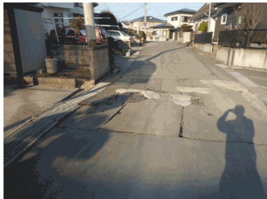
(l) アスファルトの分断・移動 (南西→北東)
