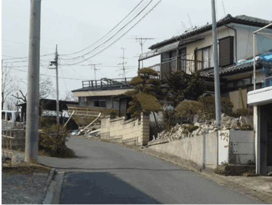
(a) 坂道途中の木造住宅の全壊 (東→西)
