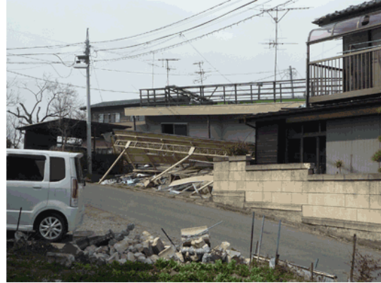
(b) 同左建築（1階部分が崩壊） (南東→北西)
