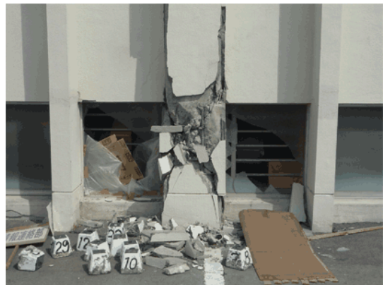
(d) 南から4番目の柱基部 （西→東）
