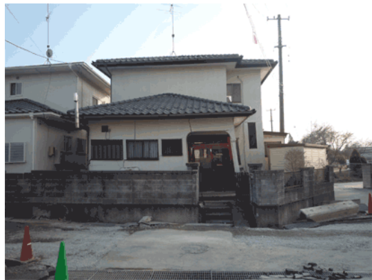
(x1) 東西路地沿いの住宅傾斜・移動 (北東→南西)
