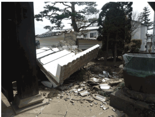
(c) 上記(b) 同じ壁（内側から撮影） (北→南)
