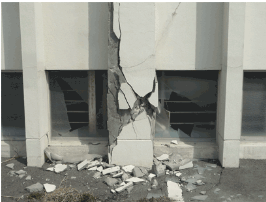
(c) 南から3番目の柱基部 （西→東）
