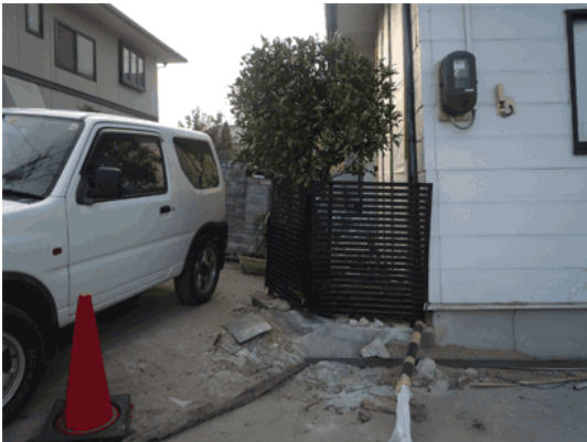
(F) 南北路地（東側）の住宅傾斜 （南東→北西）
