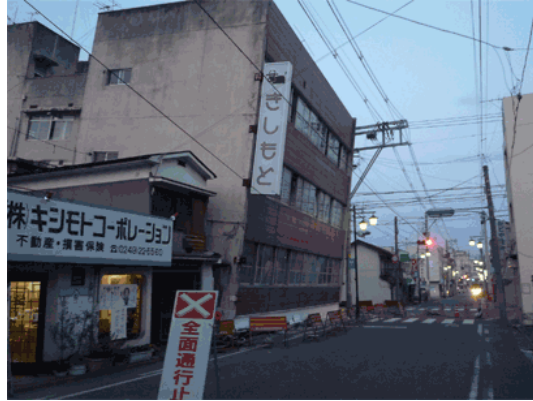
(g) 南側道路側に傾斜 (西→東)
