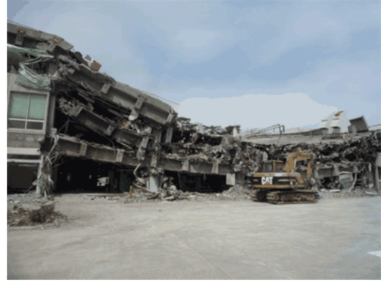
(b) 建物正面からの様子 (南→北)
