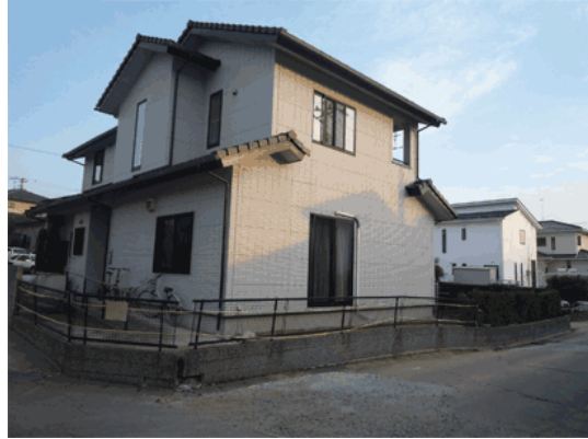
(H2) 移動境界近くの住宅（同左） （北西→南東）
