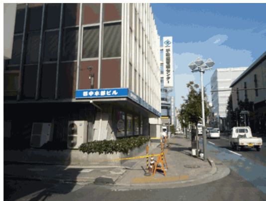
(b) RC 建物（1階部分柱の損傷） (西→東)
