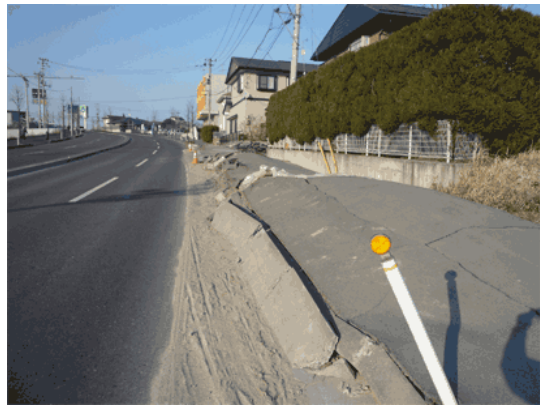
(d) 西側道路沿いの歩道 (南西→北東)
