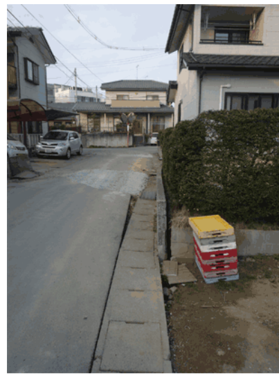
(C) 南北路地（東側）の側溝移動の様子 (南西→北東)
